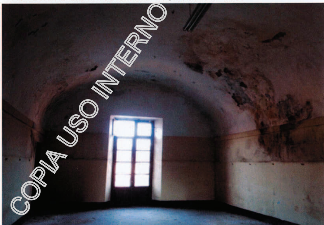
Edificio "B" Maddalena Nuova, piano secondo
