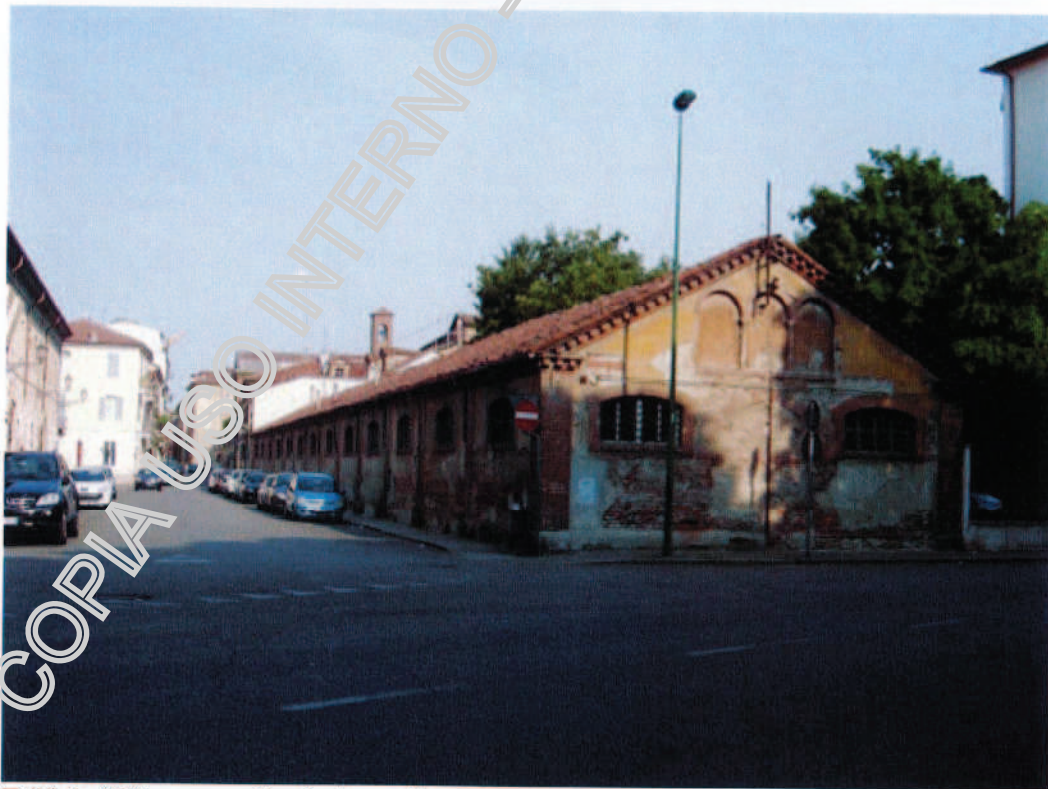
Edificio "D", prospetto via Leardi
