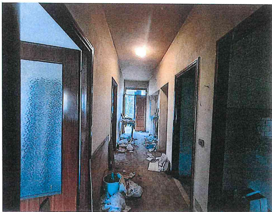
Locale disimpegno a piano primo all'interno del fabbricato
