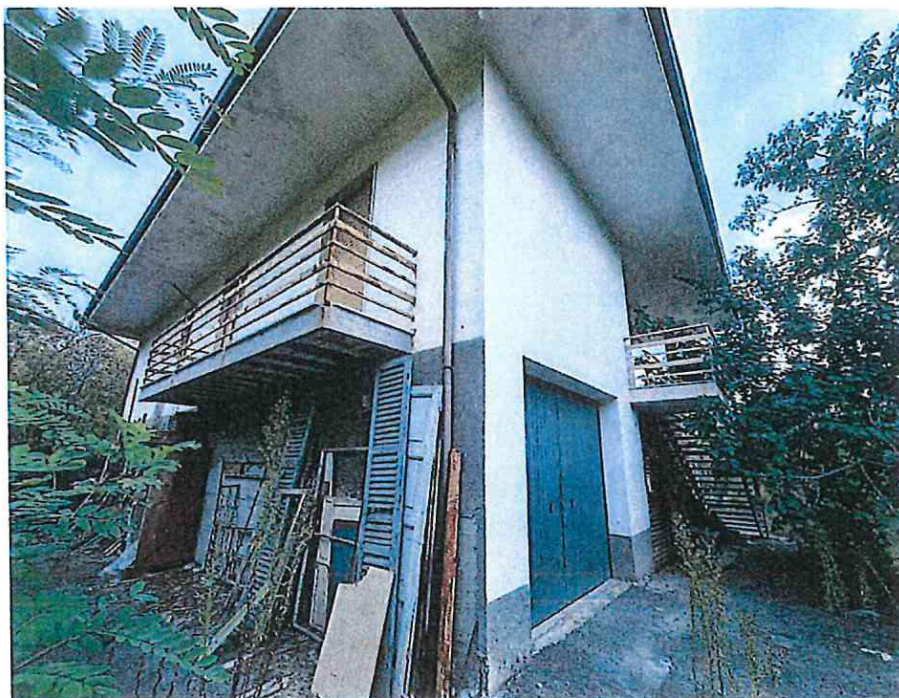
Vista generale dall'esterno fabbricato
