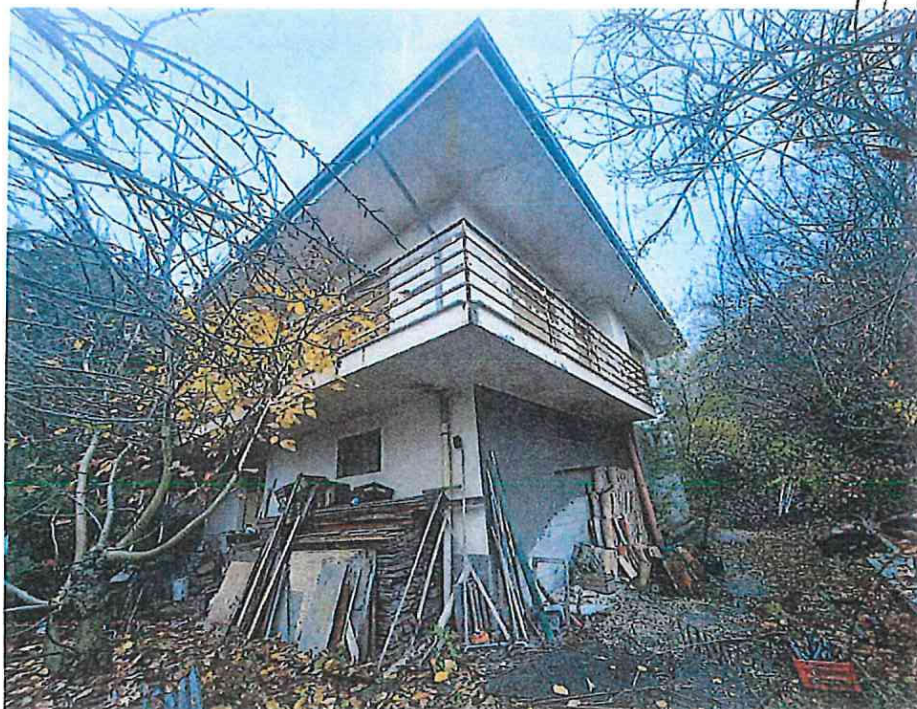
Vista generale dall'esterno fabbricato
